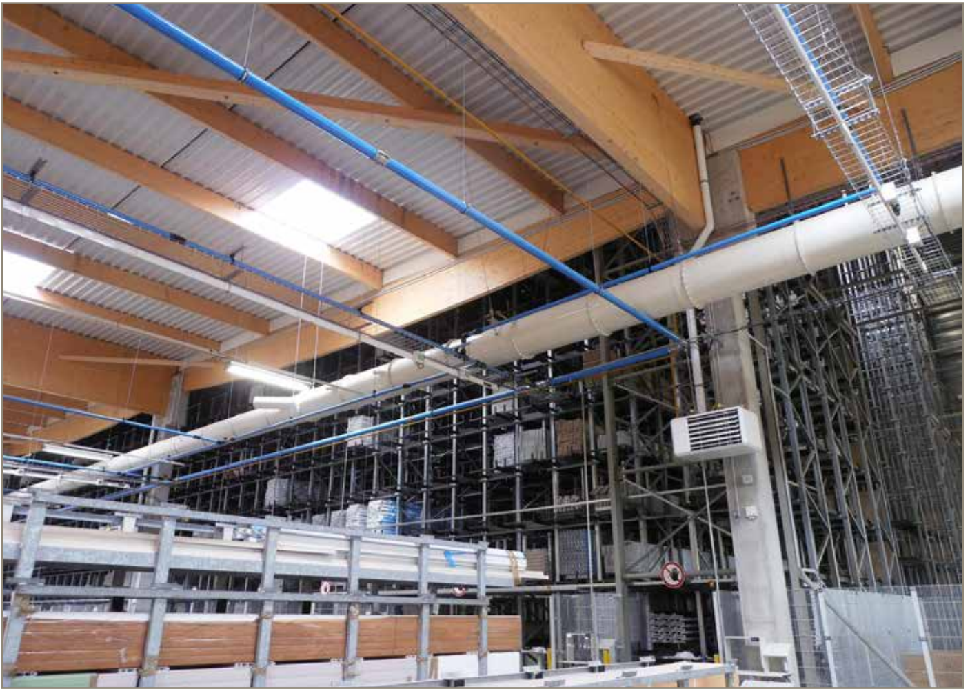
Transair®-Rohre von 25 mm (1") bis 100 mm (4") Durchmesser
